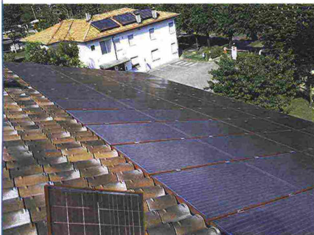
L'innovativo modulo fotovoltaico policristallino a celle rosse di Brondani Solare è costituito da 60 celle 15,6x15,6 cm e ha una potenza di 225W.
