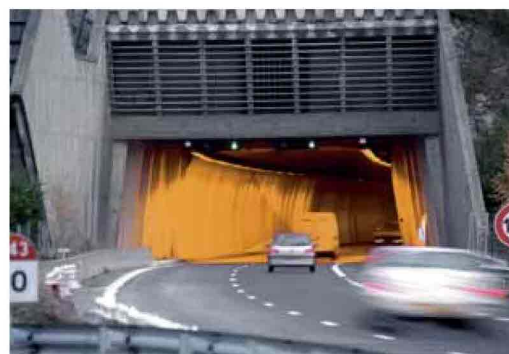
Il WiFi per videosorveglianza e antintrusione permette il telecontrollo delle parti sensibili delle infrastrutture autostradali
