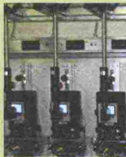
Verifica del lampeggio del Led frontale con la lettura dell'energia sul contatore
