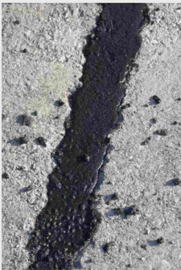
Materiale subito dopo il riempimento
