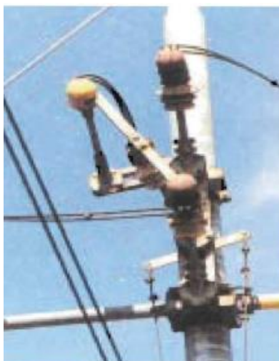
Fig. 6: Commutatore in posizione di aperto con collegamento a terra della linea
