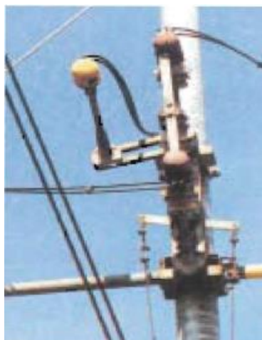
Fig. 6: Commutatore in posizione di aperto con collegamento a terra della linea
