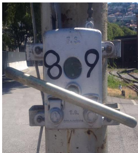
Fig. 5: Argano in posizione di aperto
