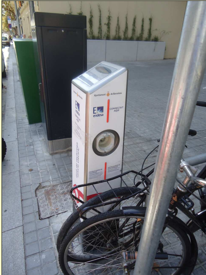
Colonnina Endesa - Spagna Inserimento diretto della presa Shuko
