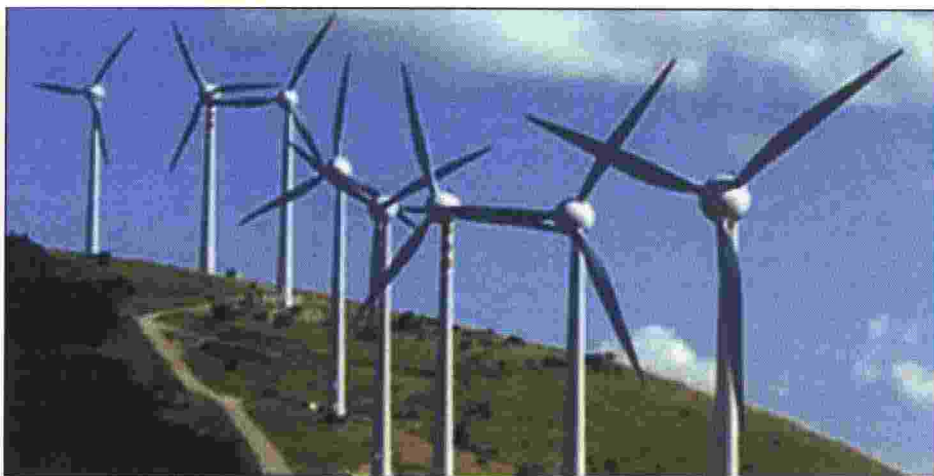
Un impianto di pale eoliche
