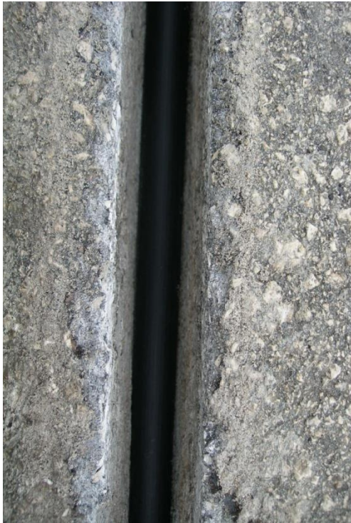
Scavo aperto con tubazione posata
