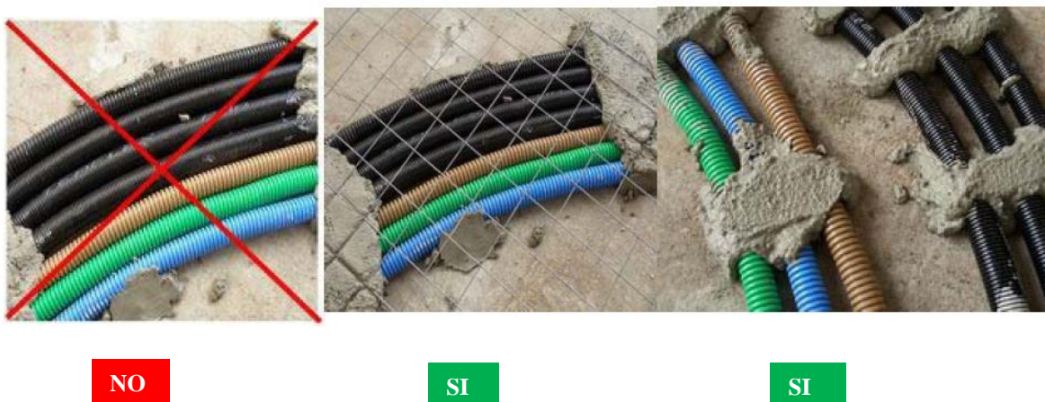
Figura 5 Esempi di posa di condutture a pavimento
