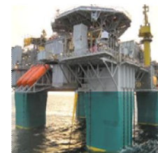
Gjøa 40MW AC, 100km
