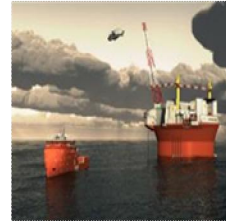
Goliat 60MW AC 100km
