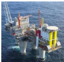
Troll 1 - 4 4 * 43 MW HVDC 2 * 20 MW AC
