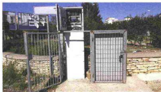
Tipologie di quadro package per una ODU stradale a sinistra e sotto e per un bacino biologico in alto a destra
