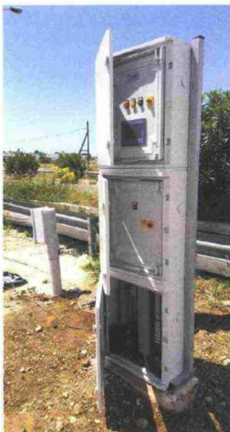
Tipologie di quadro package per una ODU stradale a sinistra e sotto e per un bacino biologico in alto a destra
