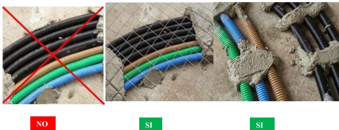
Figura 5 Esempi di posa di condutture a pavimento
